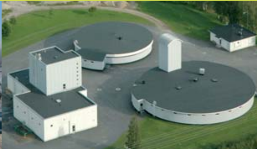
Kommunale Kläranlage in Kurikka, Finnland
